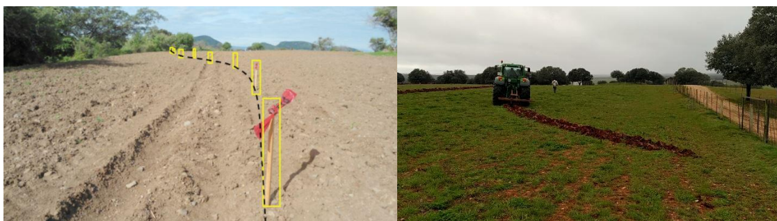
Figura 6 e 7: Marcatura con picchetti; marcatura diretta con stazione GPS e attrezzo da lavoro adattato allo scopo.
